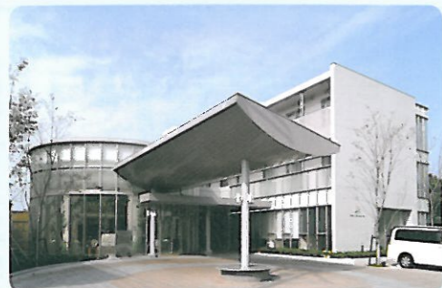
緩和ケア病棟を備えた【メディカルケアセンターファイン】
